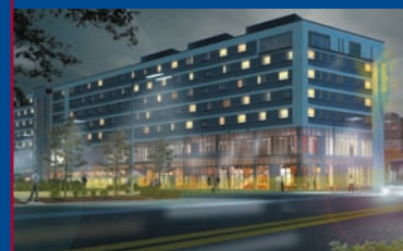
06/2009 Zatknięcie wiechy na Hotelu angelo w Jekaterynburgu (197 pokoi)
