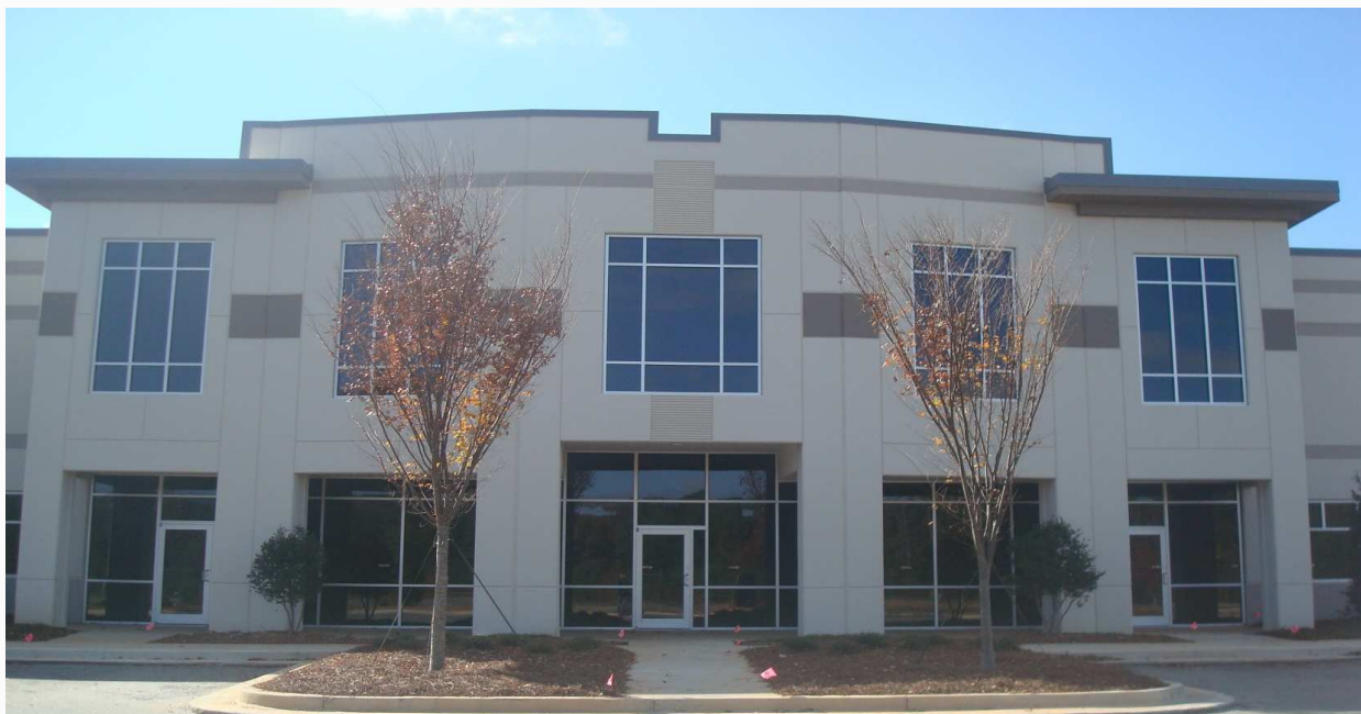
Zdj. Nowa siedziba HTL-STREFA, Inc. w Marietta, Georgia
