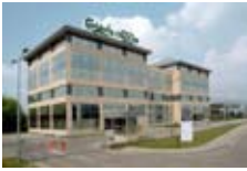
PL, Warszawa, Bokserska Distribution Center
