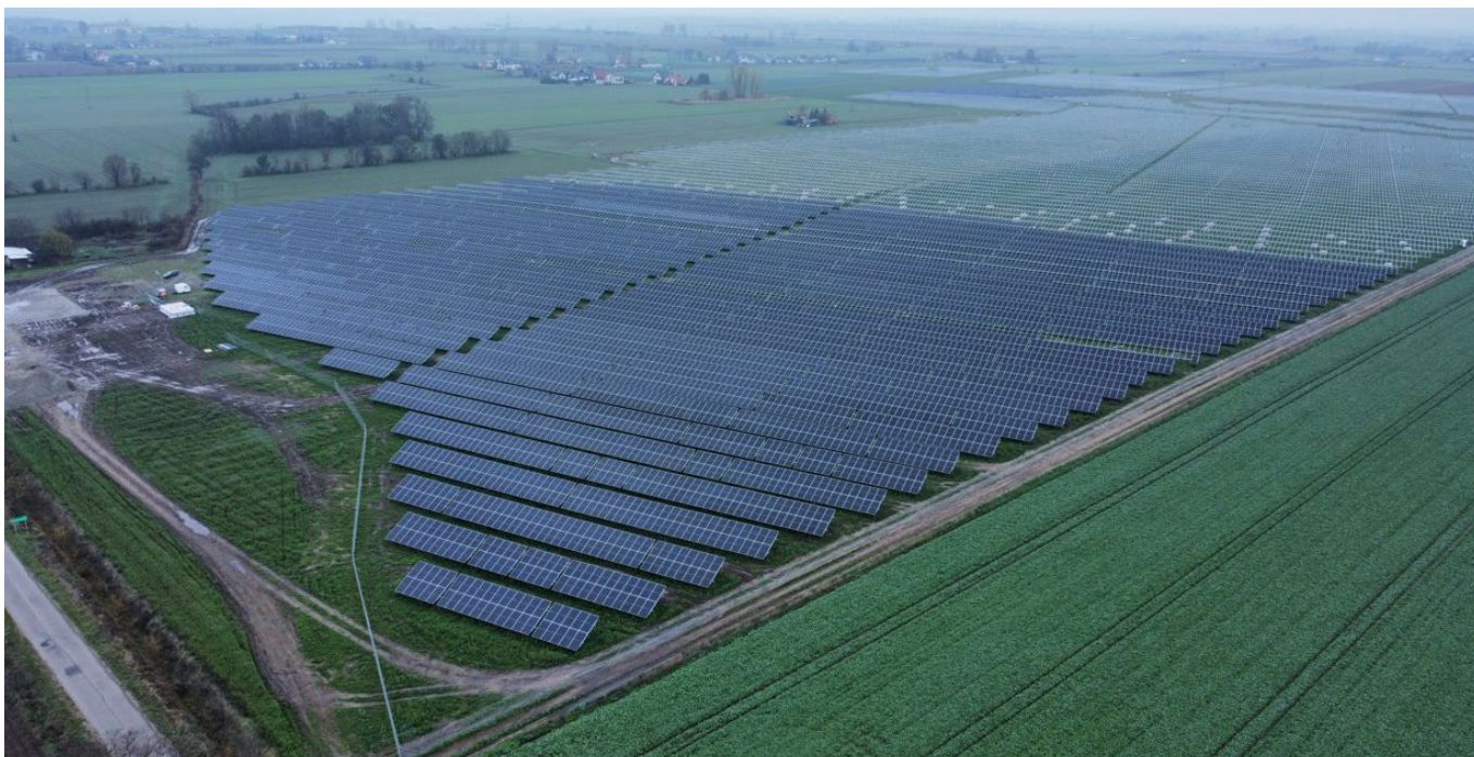
Stan budowy projektu Kleczew Solar &amp; Wind – listopad 2022
