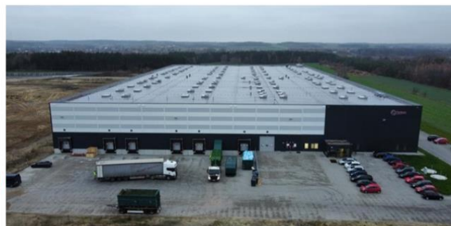
BUDOWA HAL MAGAZYNOWYCH W RAWIE MAZOWIECKIEJ
