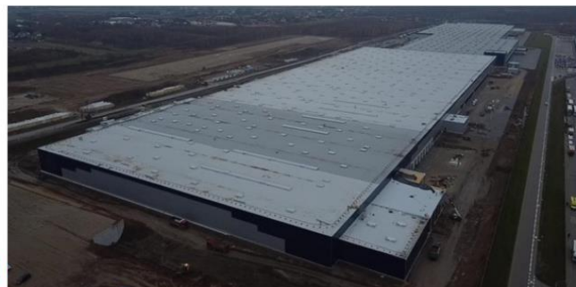
BUDOWA MEDIA EXPERT
