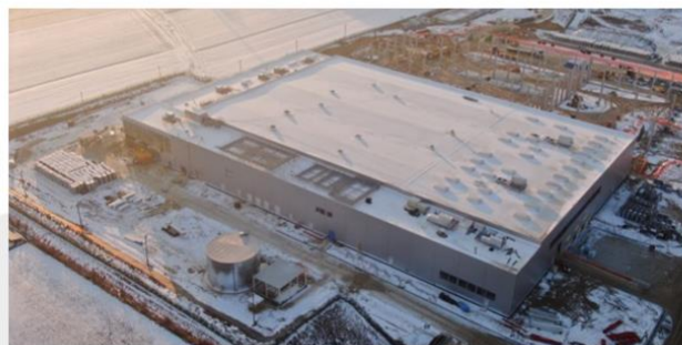
OBIEKT PRODUKCYJNY SIEMIANOWICE ŚLĄSKIE
