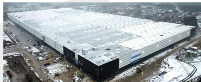
DOSTAWA I MONTAŻ POKRYCIA DACHU ZALANDO
