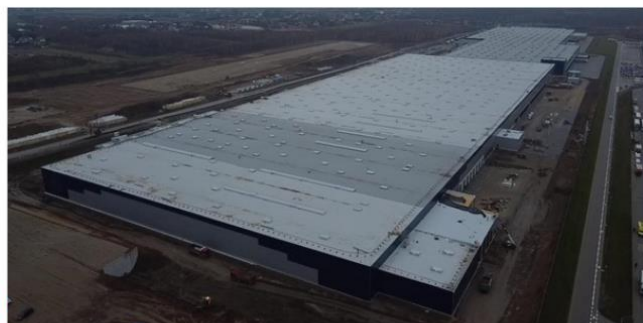
BUDOWA MEDIA EXPERT
