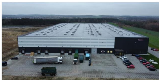
BUDOWA HAL MAGAZYNOWYCH W RAWIE MAZOWIECKIEJ
