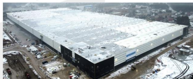
DOSTAWA I MONTAŻ POKRYCIA DACHU ZALANDO
